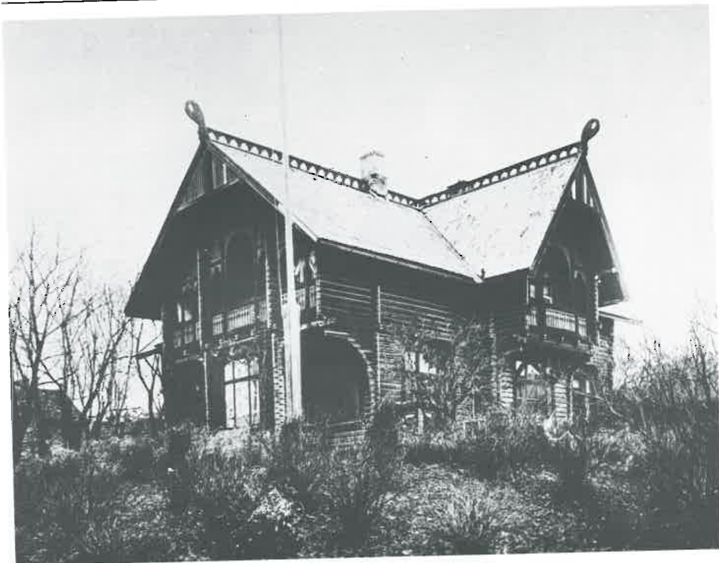
Villaen som Anders Sandvig bygde i Jernbanegata like ved jernbanestasjonen, var i dragestil, en populær stilart i tida omkring århundreskiftet.
